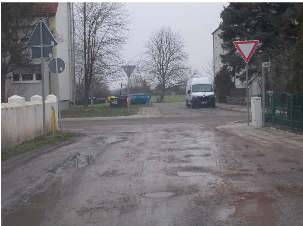
Seitenbereich fachgerecht nachprofilieren sowie den Straßenbereich im Bereich der Baken bis zur Rathmannsdorfer Straße nachverdichten und profilieren.
