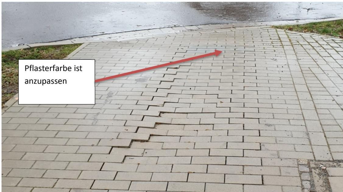
Abgesackter Pflasterbereich Rathmannsdorfer Straße/Ecke Güstener Weg aufnehmen, fachgerecht verdichten und erneut pflastern. Das graue Pflaster auszutauschen und durch Pflaster in der Farbe des kompletten Gehweges zu ersetzen.
