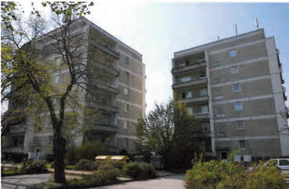
Die Wohnblöcke in der Bernburger Straße 11+12 sind Teil des Abrissbestands. Durch verbaute Glasleitungen und die dadurch entstandenen Schäden sind sie unsanierbar und müssen abgerissen werden.
